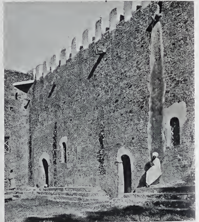
Abb. 16. Überwölbte Tür- und Fensteröffnungen an der Zionskirche zu Aksum.
